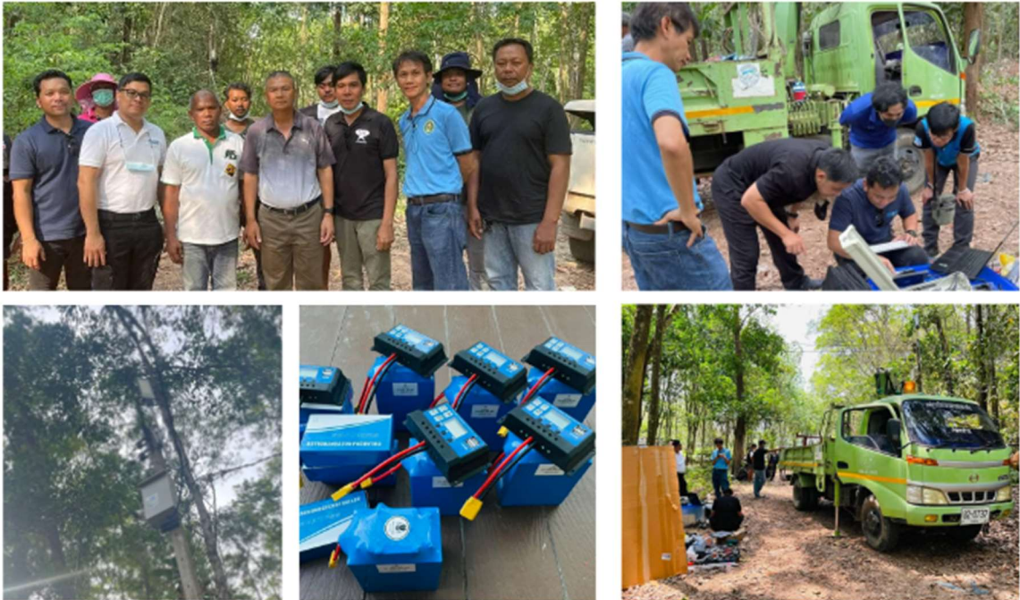
ภาพที่ 12 การติดตั้งบริเวณทุ่งควายกิน อำเภอกงหรา จังหวัดระยอง
